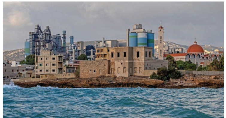
Basée à Chekka (Liban-Nord), la Cimenterie nationale emploie 750 personnes.
